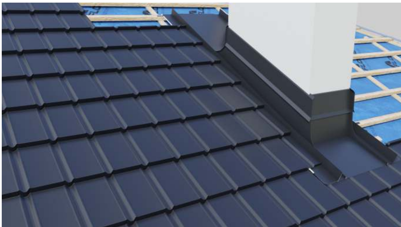
Panele zamontowane wzdłuż obróbki.
