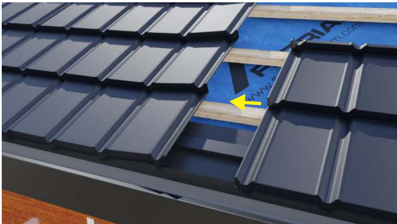
Zamontowana blachodachówka
