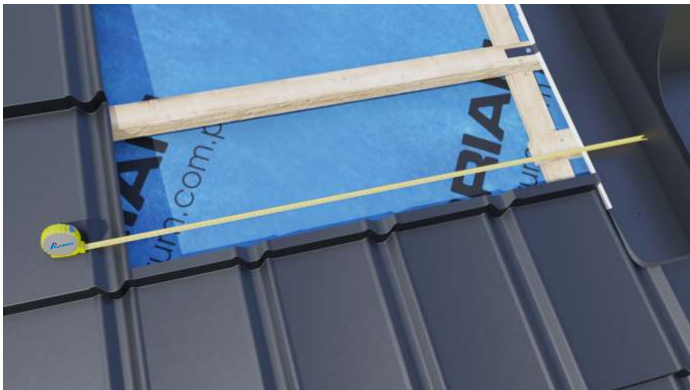
Odmierzanie szerokości blachodachówki obok komina.
