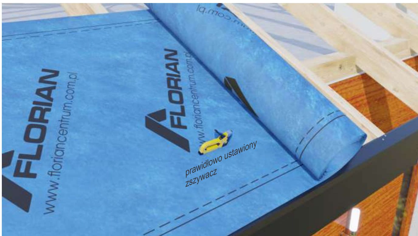
Układanie membrany.
